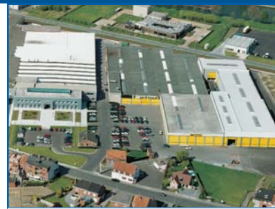
Le siège principal de WINSOL est situé à Izegem.
